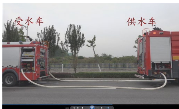
自动供水受水
